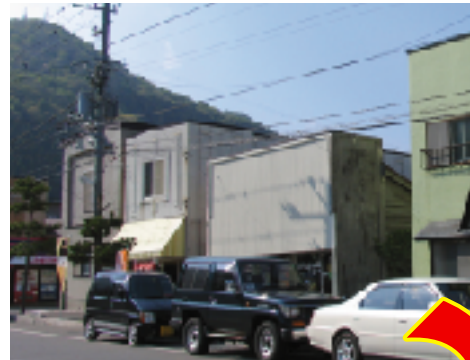
塗り替え前の町並み
