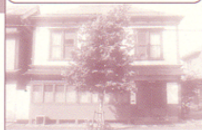
ペンキ塗り替え対象町家① 加藤家住宅の正面外観
